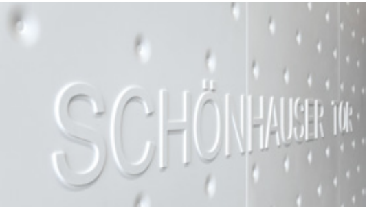
Une animation pleine d'effets à l'extérieur, à l'intérieur un agencement net de points et de lettres fraisées en recourant à l'usinage CNC.
